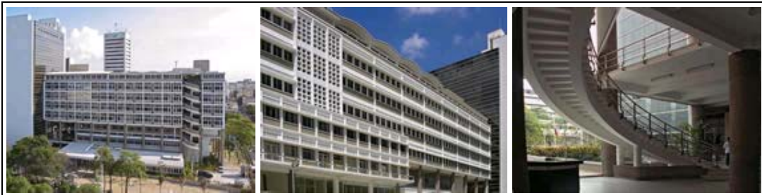
Restauración del Centro Cívico y el Edificio de Despachos Judiciales Lara Bonilla Barranquilla, Atlántico Arq. Roberto Rafeael Ángulo García
